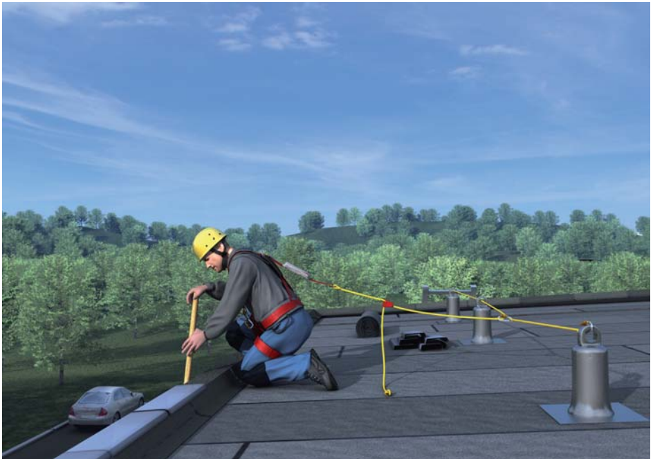
Dauerhafte Anschlagrichtungen zum Befestigen persönlicher Schutzausrüstung gegen Absturz (Quelle: BG BAU, Bausteine)
