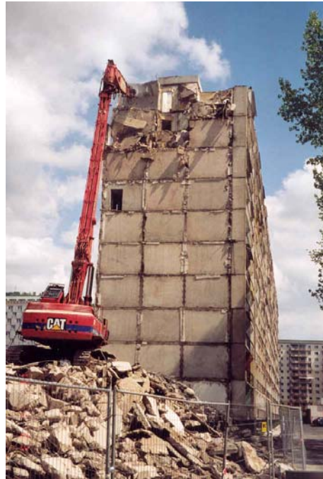
Abbruch mit Longfrontbagger
