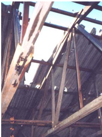
Durchbruch durch Wellasbest-Dach
